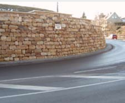
Stützmauer in der Ortsdurchfahrt Utenbach (L: 75 m, B: 1,14 m, höchste Höhe: 3,26 m)
