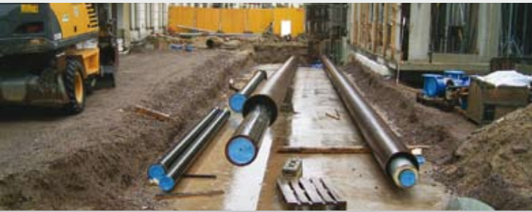
Leitungsverlegung Töpferstraße in Dresden
