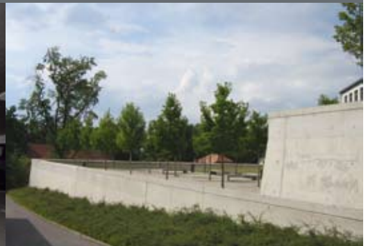
Snozzi-Mauer im Wohngebiet „neues bauen am horn“ in Weimar (L: 250m, B: 1,60m, höchste Höhe: 5m)
