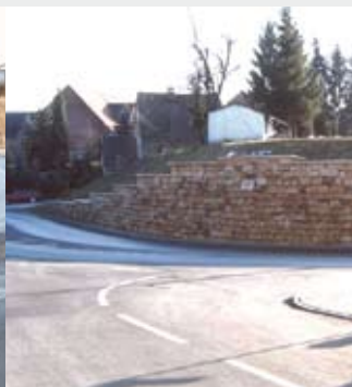
Stützmauer in der Ortsdurchfahrt Utenbach (L: 75 m, B: 1,14 m, höchste Höhe: 3,26 m)
