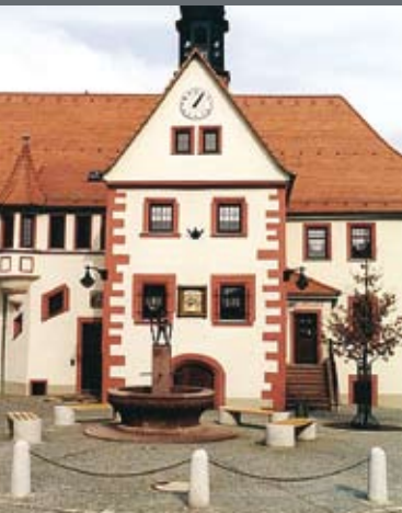
Sanierung des Marktes
