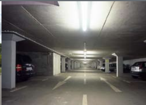
Tiefgarage im Wohngebiet „neues bauen am horn“, Weimar
