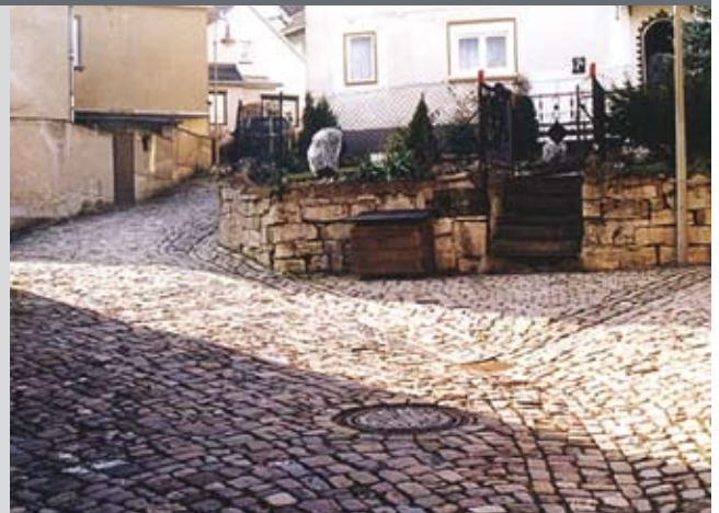
Sanierung Schloßberg Kranichfeld
