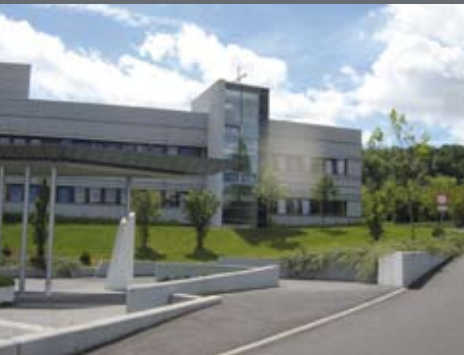
Retaining walls on the premises of the clinical centre Sophien- und Hufeland-Klinikum in Weimar
