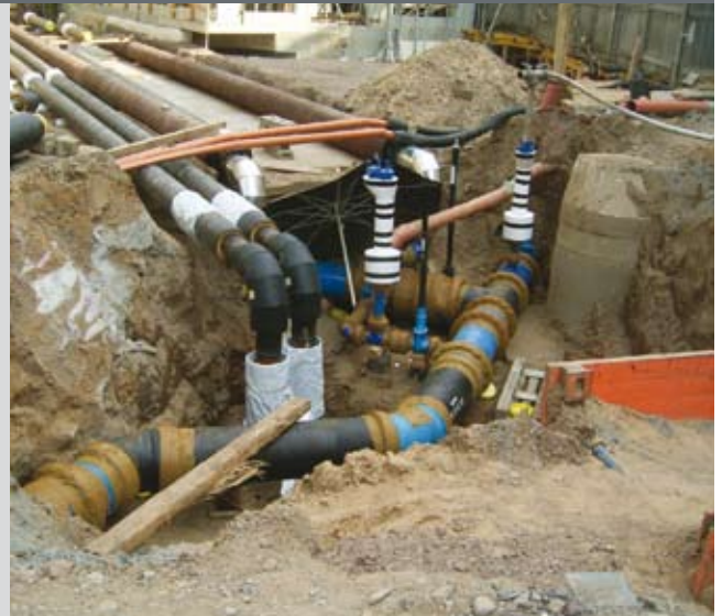
Junction Augustusstraße in Dresden
