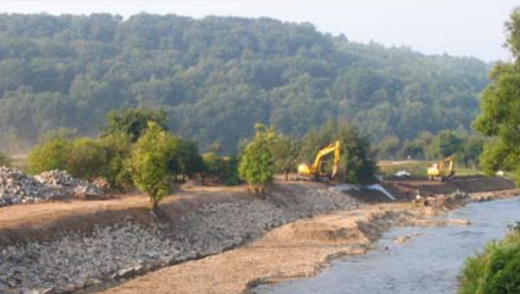
Ufersicherung Raba bei Zeitz
