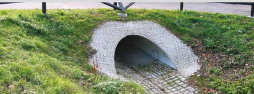
Neuer Durchlass im Batschkelauf
