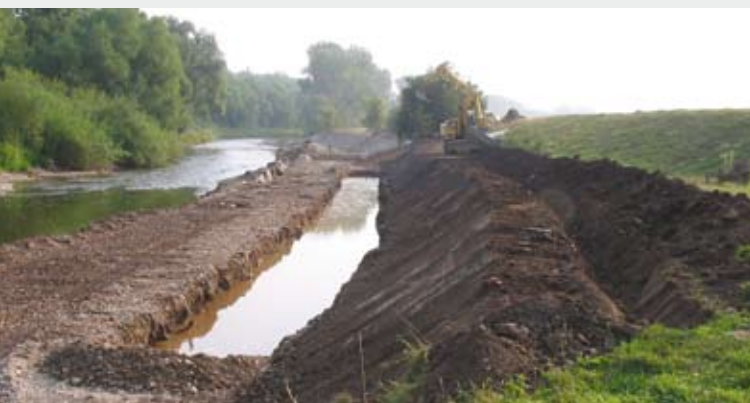
Bauarbeiten am Deichabriss
